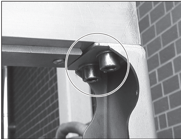
Pav. 5.21 Kreipiančiojo bėgio veržlių atsukimas (vaizdas iš apačios)
